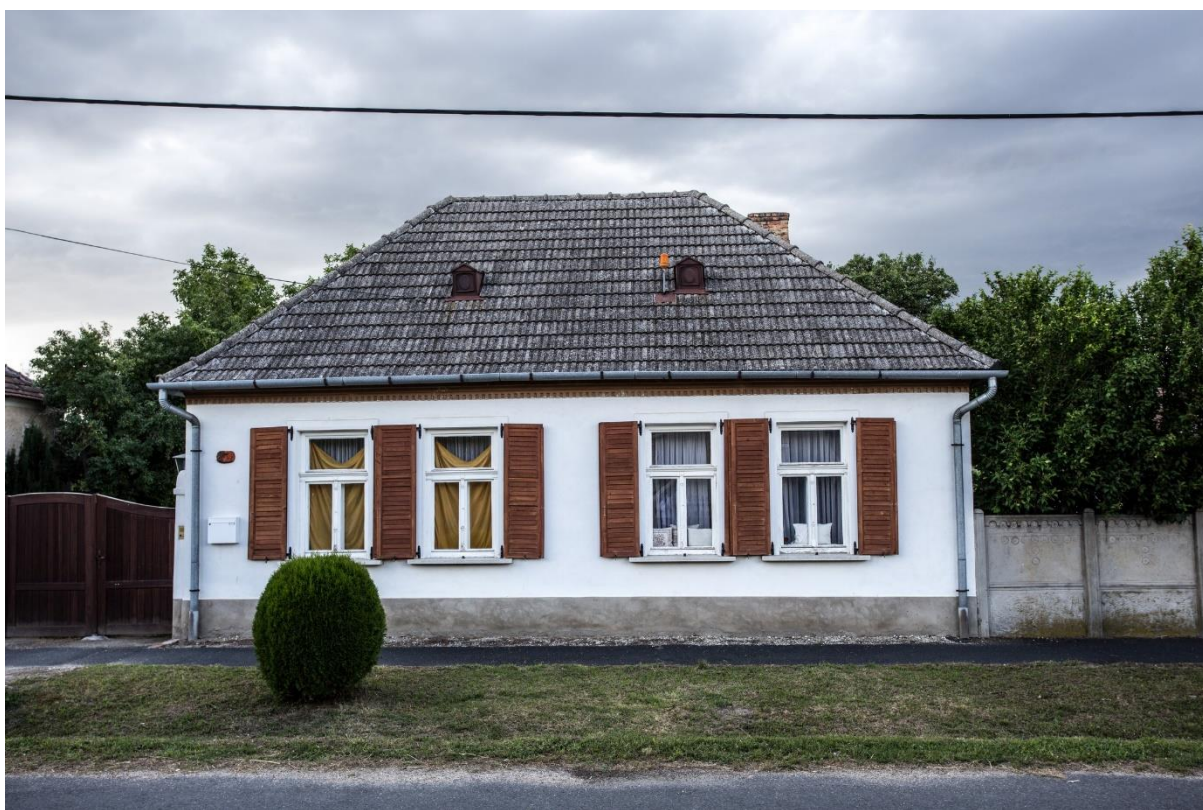
Ófaluban felújított ház: figyeljük meg a felújított tetőszellőzőket, eredeti formájukban megőrzésre kerültek. Spaletták kerültek használatra.
